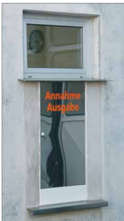
Das Annahme- und Ausgabesystem ist für Kunden von außen zugänglich
